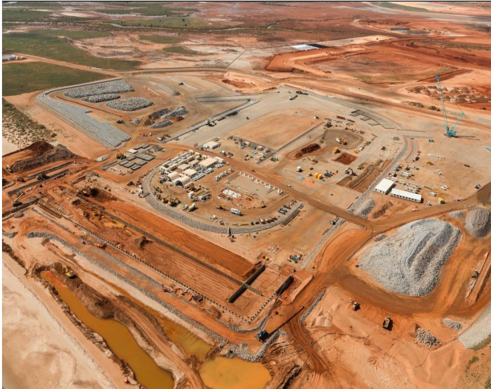
Piling, on-shore LNG processing plant
