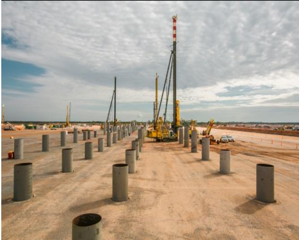
Piling, on-shore LNG processing plant
